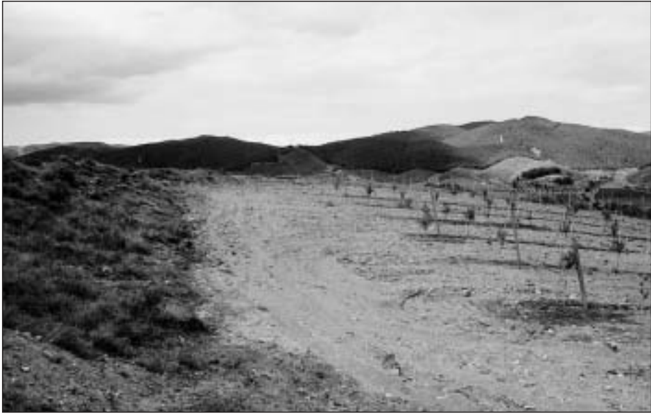
Foto 15. Cata 4. Localización antes de iniciar la excavación
